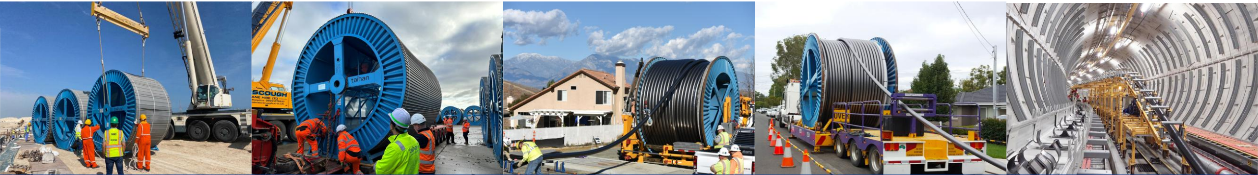
카타르 지중 송전망 GTC 956 영국 런던 파워 터널 2단계 SCE 500kV 지중 송전 프로젝트 호주 시드니 지중 전력망 싱가포르 NDC199
